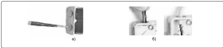
Рисунок 3. Ввод кабеля внутрь корпуса
